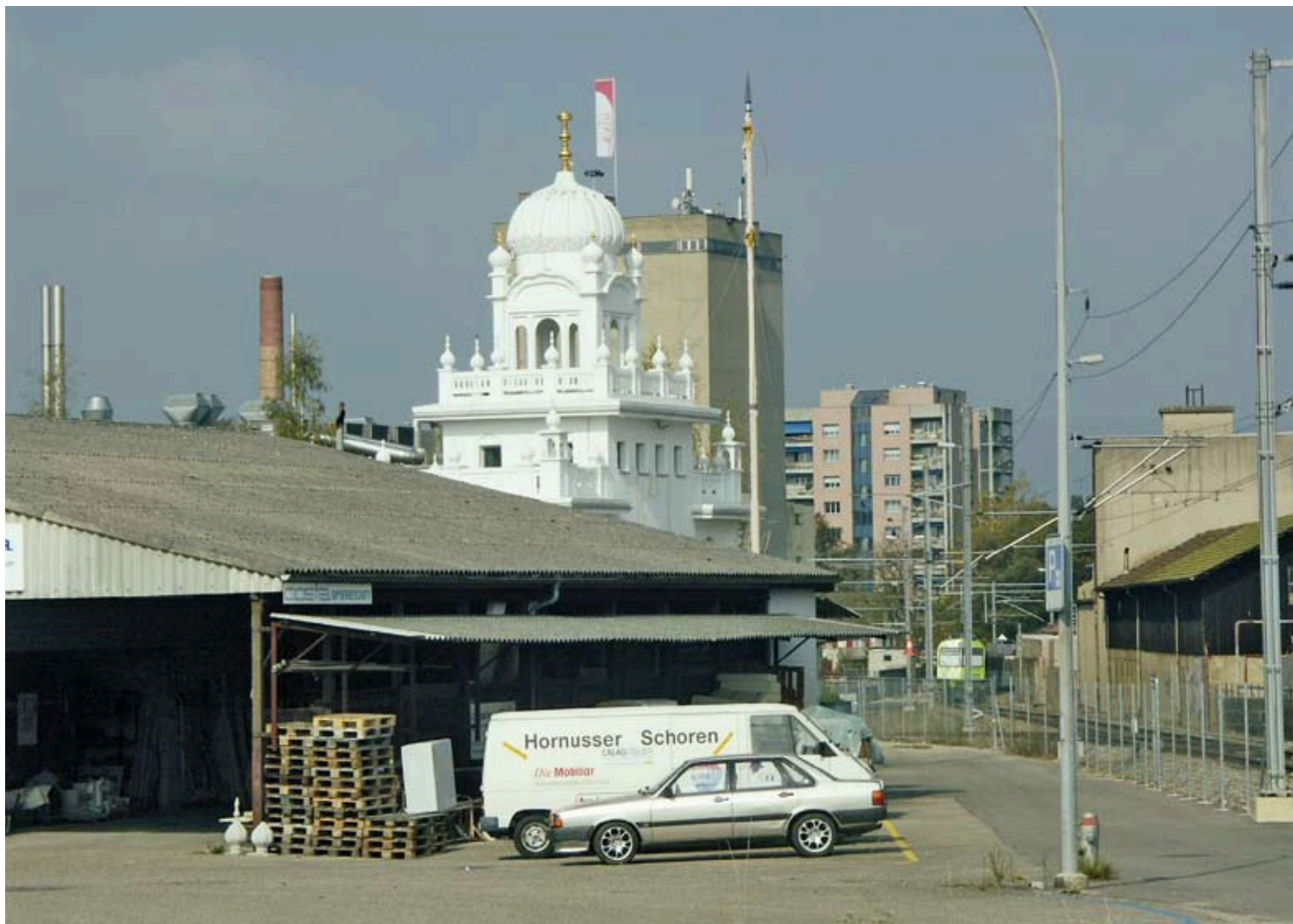
Der Gurdwara der Sikhs in Langenthal steht nahe der Bahnlinie im Industrie- und Gewerbequartier. Die benachbarte Gipserei lieferte die zwiebelförmigen Aufsätze für die umlaufende Brüstung auf dem Dach. Im Gegensatz zum geplanten Minarett in derselben Stadt löste dieser Bau keine Kontroverse aus. (Foto: Edwin Egeter)
